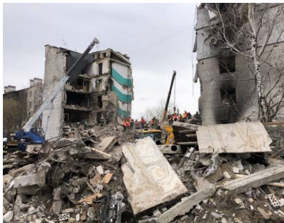
Рис.1. Зруйнована будівля внаслідок обстрілу
